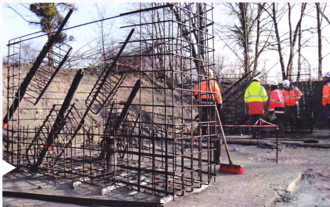
Construction des fondations de part et d'autre du Rhône - Février 2019
